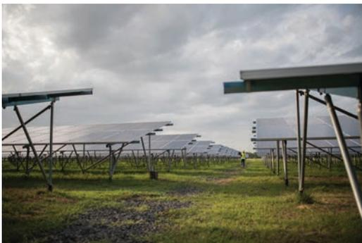
Un impianto agrivoltaico viene installato a un'altezza tale da consentire il passaggio degli animali, delle macchine agricole e la coltivazione.
