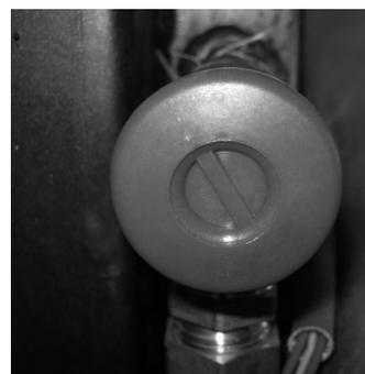
**Valvola di sicurezza:** questa valvola interviene per prevenire una sovrappressione dell'impianto idraulico. Se la pressione della caldaia o dell'impianto supera i 2,5 bar essa scarica l'acqua dal circuito.
