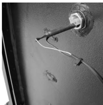
**Sonda di temperatura acqua:** se la temperatura dell'acqua si avvicina alla temperatura di blocco (100°C) la sonda impone di interrompere l'alimentazione del pellet.
