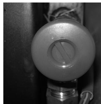
**Valvola di sicurezza:** questa valvola interviene per prevenire una sovrappressione dell'impianto idraulico. Se la pressione della caldaia o dell'impianto supera i 2,5 bar essa scarica l'acqua dal circuito.
