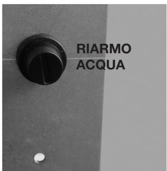
**Termostato di sicurezza a riarmo manuale per la temperatura dell'acqua:** se la temperatura dell'acqua supera il valore di sicurezza impostato a 100 °C si arresta immediatamente il funzionamento della caldaia e sul display apparirà la scritta **"ALAR-SIC-FAIL"**. Per riavviarla è necessario ripristinare il termostato manualmente.
